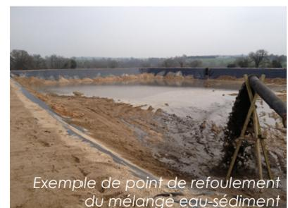
Exemple de point de refoulement du mélange eau-sédiment
