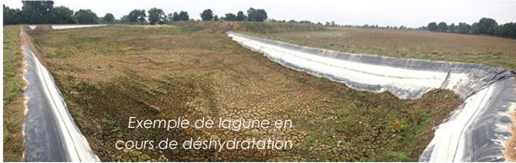
Dès que la phase de remplissage des lagunes est terminée, le rejet est amorcé. Le suivi de la qualité des eaux rejetées (en sortie de lagune) permet, si la concentration en MES est trop élevée, de moduler le refoulement et de jouer
